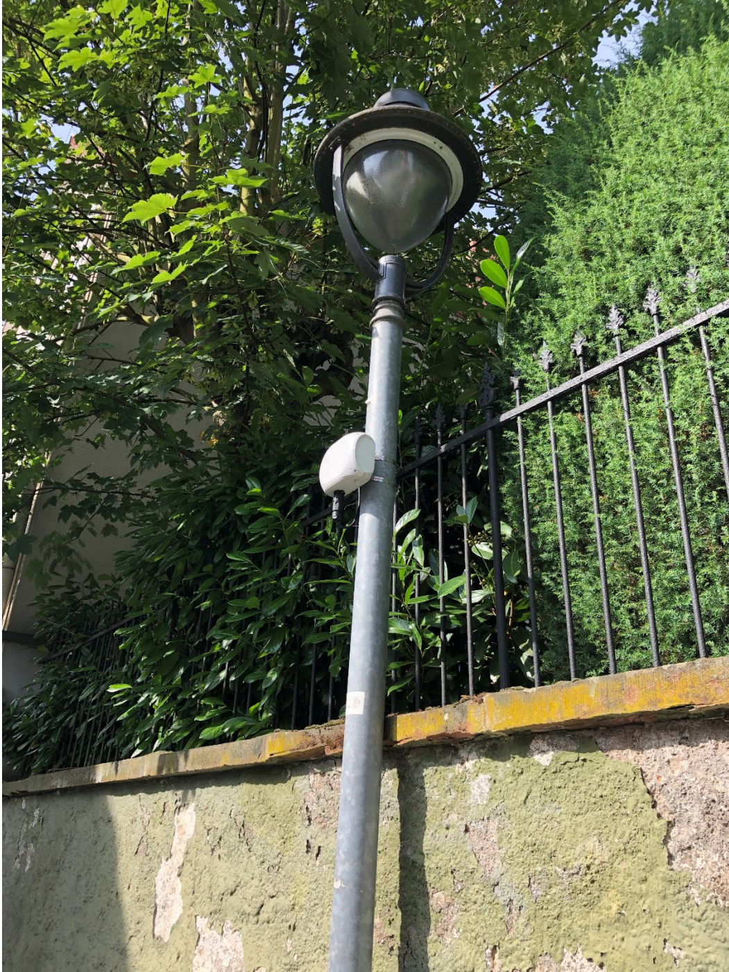
Installierter RF-Tracker in Bad Nauheim
